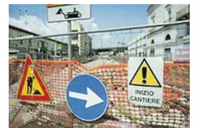
Un cantiere stradale
